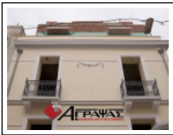
Ανακατασκευή Νεοκλασικού Ανακατασκευές Οκτ '10
