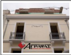
Ανακατασκευή Νεοκλασικού Ανακατασκευές Οκτ '10
