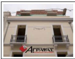
Ανακατασκευή Νεοκλασικού Ανακατασκευές Οκτ '10
